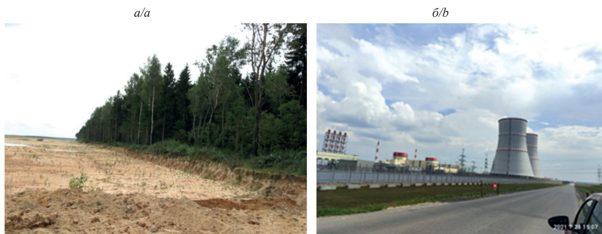
Рис. 2. Вид Островецкой площадки в начале строительства БелАЭС: а) 2012 г.; б) 2021 г. (фото О. В. Лозинской)
