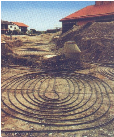
Рис. 13. Принцип устройства горизонтального циркуляционного контура (кольцевая укладка)
