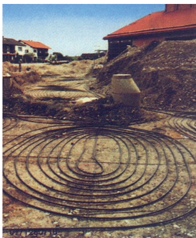
Рис. 13. Принцип устройства горизонтального циркуляционного контура (кольцевая укладка)
