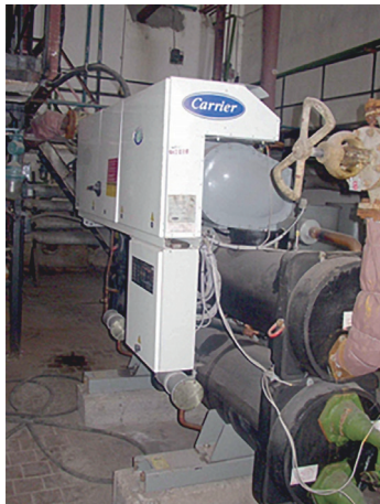
Рис. 14. Тепловой насос (а) и отапливаемый им комплекс сооружений канализационной насосной станции № 24 в д. Новый Двор Минского района (б).
