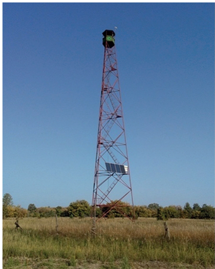
Рис. 2. Фотография ПРМВК, оборудованного солнечной электростанцией
